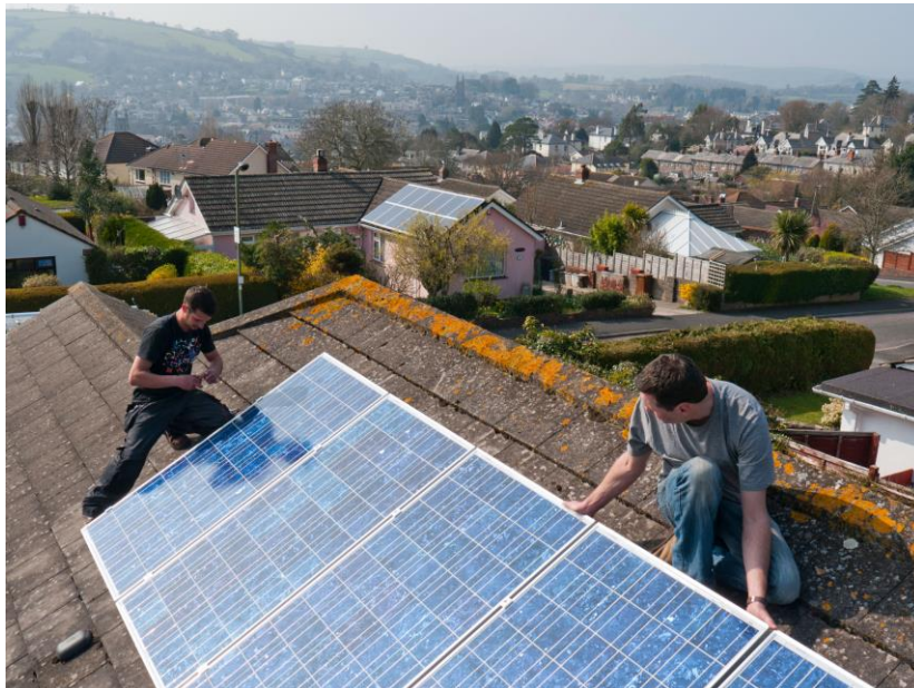
Σχήμα 10: Συμμετέχοντες στο κίνημα των πόλεων μετάβασης που εγκαθιστούν ηλιακούς συλλέκτες σε στέγη
